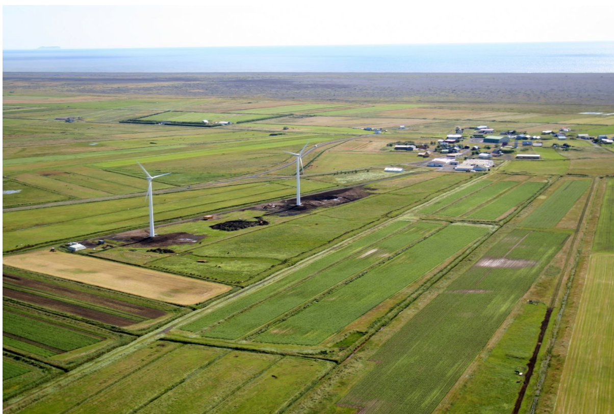
MYND 2.1 Mynd af gömlu vindmyllunum tveim norðan við Þykkvabæ. Nýju vindmyllurnar verða lægri. Myndin er tekin á framkvæmdatíma og ekki er búið að ganga frá við undirstöður. Mynd: AOPA Ísland
